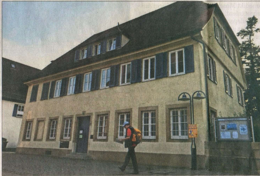
Die Geschichtswerkstatt erhält im Dekanatshaus einen 21 Quadratmeter großen Arbeitsraum und eine Lagerfläche. Kommendes Jahr könnte es noch mehr werden. Foto: Julia Bosch
